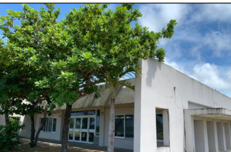
1. B棟入口現況
