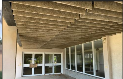
5. A棟入口現況
