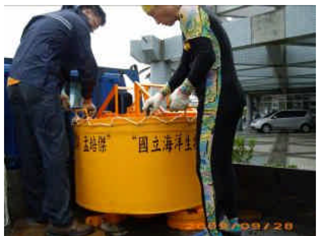
圖 2-7 工作人員開始安裝作業
