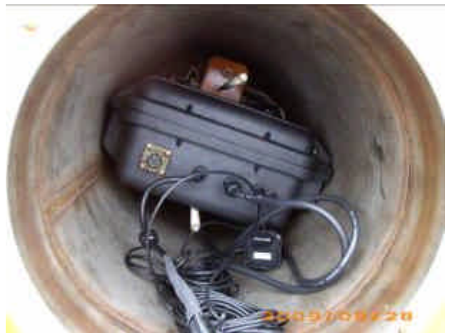
圖 2-11 控制系統與電力系統內部情形
