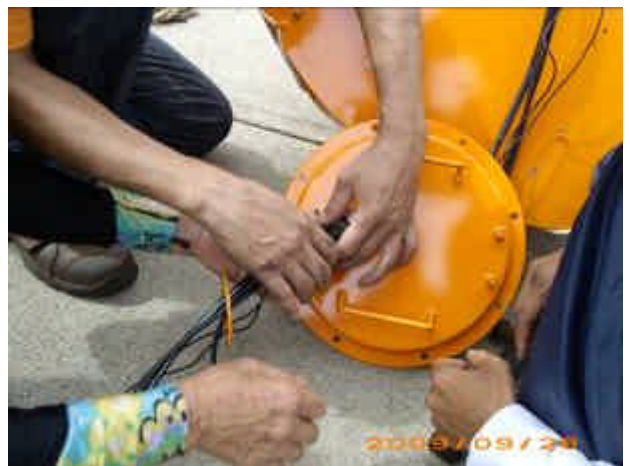
圖 2-13 訊號線與密封蓋施工作業
