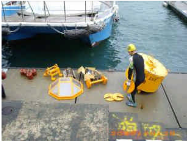
圖 2-8 進行底部重錘安裝作業
