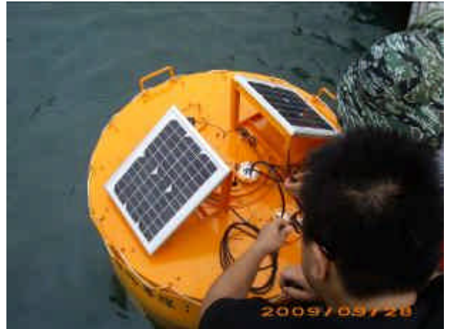
圖 2-15 浮標置入水中並安裝太陽能板
