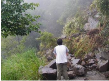
照片 3-1 楠梓仙溪林道 6 月崩塌
