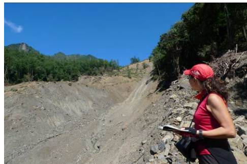
照片 3-2 楠梓仙溪林道 10 月 12.5 公里處走山
