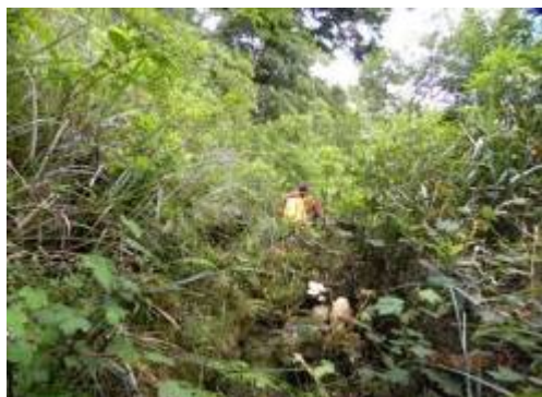
玉山林道崩塌路段
