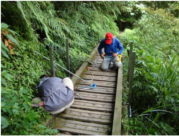
圖 5.5、中之關端架設支撐柱
