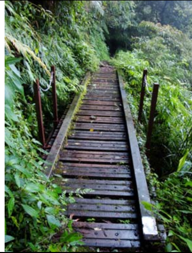
圖 5.6、中之關端支撐柱完工圖
