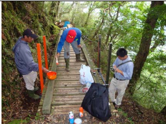
圖 5.7、天池端架設支撐柱
