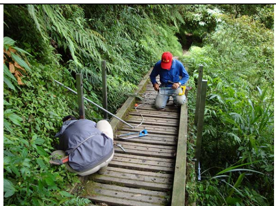
圖 4.2 中之關端第二十號棧木橋設置位置
