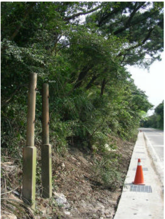
照片二十九、陽金公路施工路段(黃俊嘉攝)。
