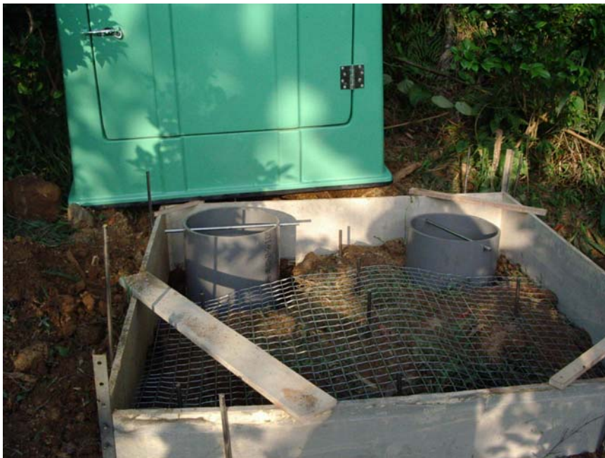
圖十三 (a) 微震站水泥台之施工情形。
