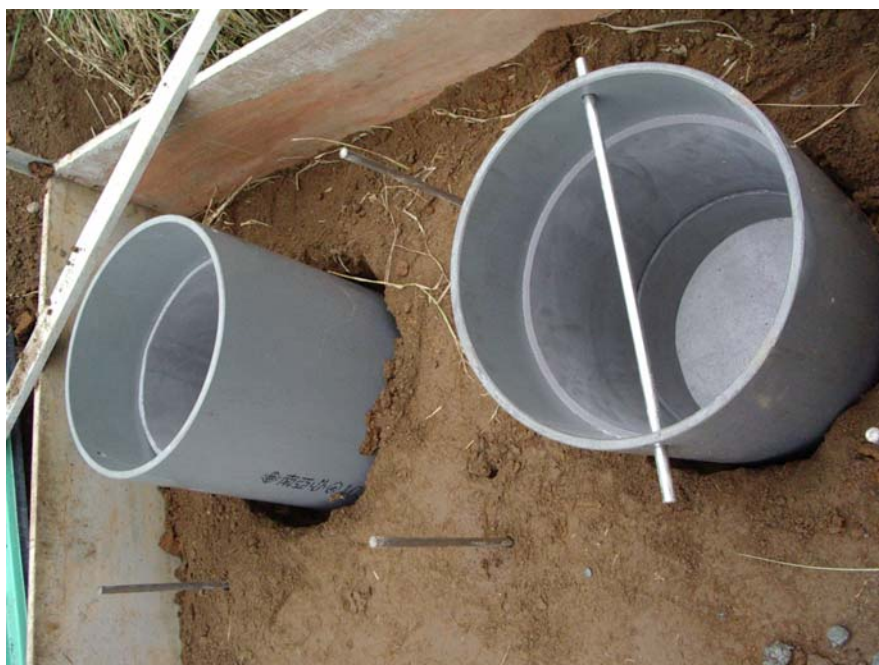
圖十三 (c) 微震站感應器放置孔之施工情形。
