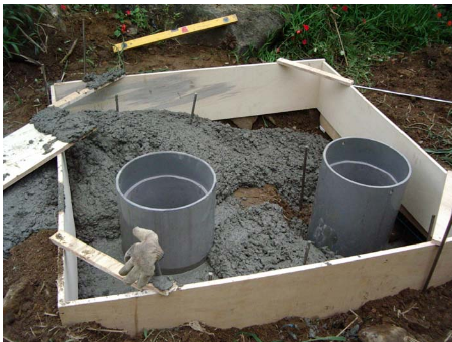
圖十三 (b) 微震站水泥台之施工情形。
