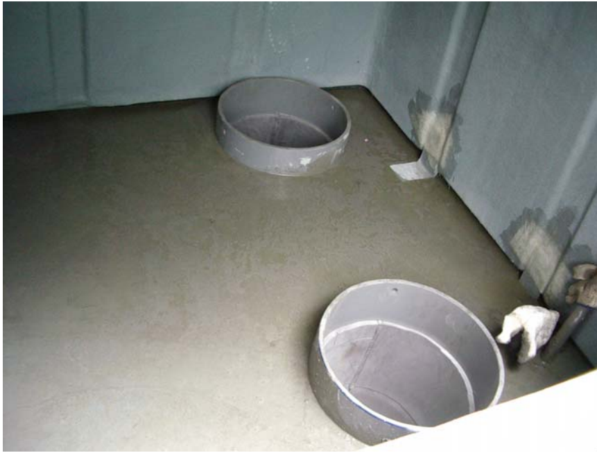
圖十三 (d) 微震站水泥台之施工完成情形。
