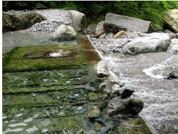
葫蘆谷支流自來水取水堰
