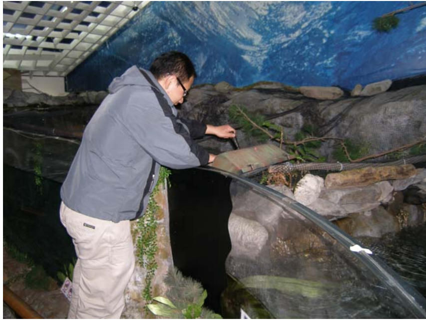
拆開上蓋更換變電器
