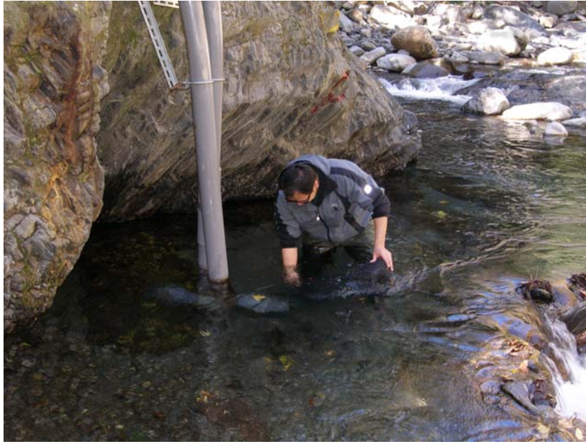
再抽水口加裝隔網以防落葉塞住
