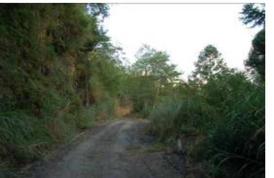
圖七、工程後破壞原先架網處
