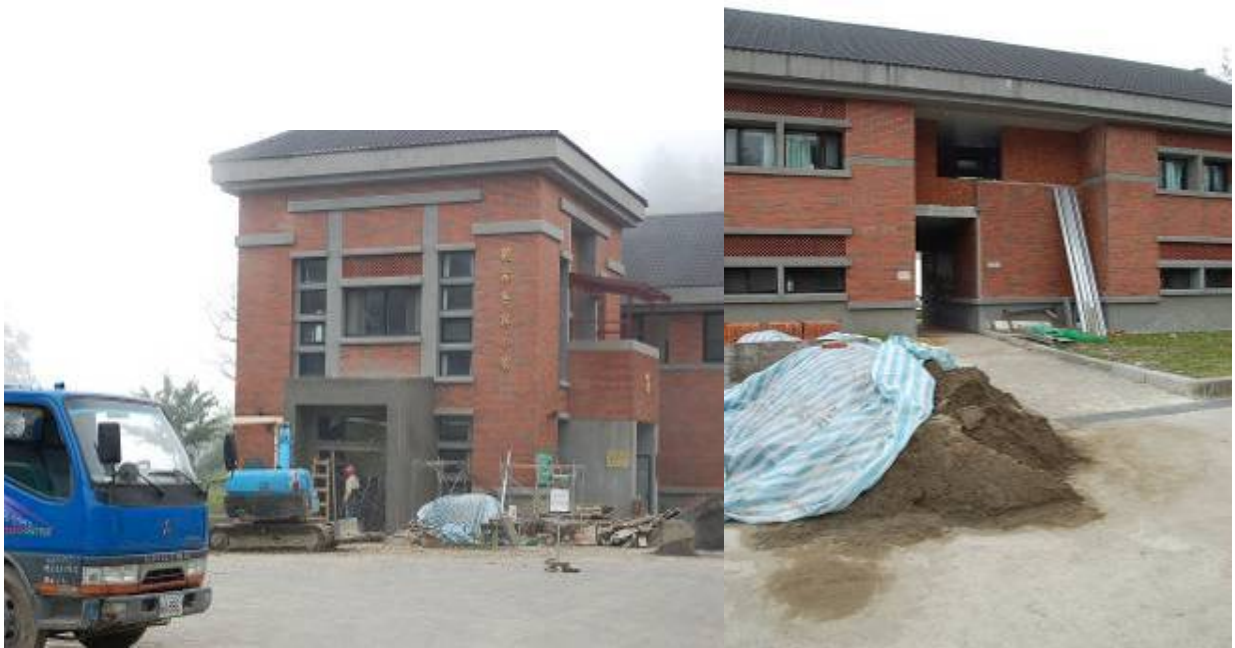
圖二十八、觀霧管理站施工狀況
