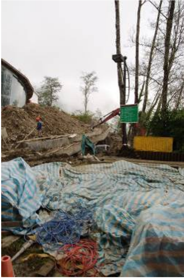
圖二十七、林務局遊客中心周邊施工狀況
