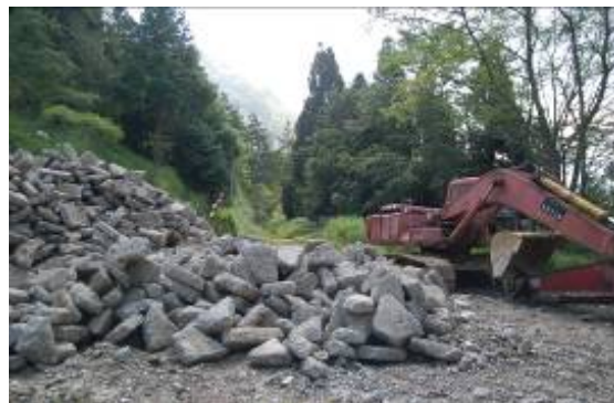
圖五 大鹿林道東線工程進行中
