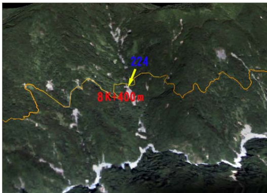
圖 5-35 上下邊坡崩坍情形
