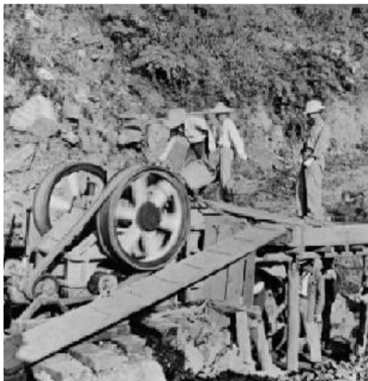
照2-3-5 碎石機打出碎石，墊鋪路面 照片來源：東勢林區管理處提供
