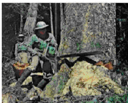
3.自倒向口相反部位鋸入背口
