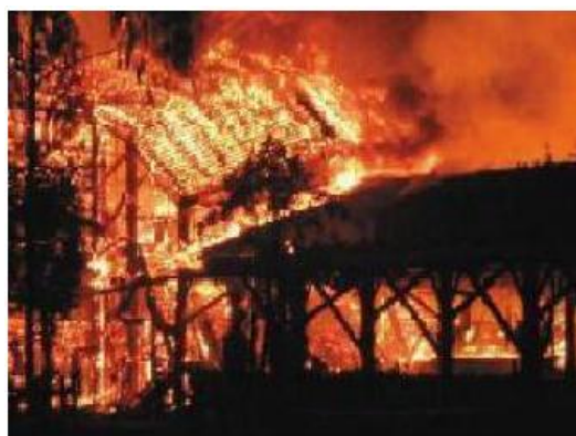
照2-7-2 民國95年大製材廠火災情形 照片來源：大雪山製材廠災後清理計畫，2008
