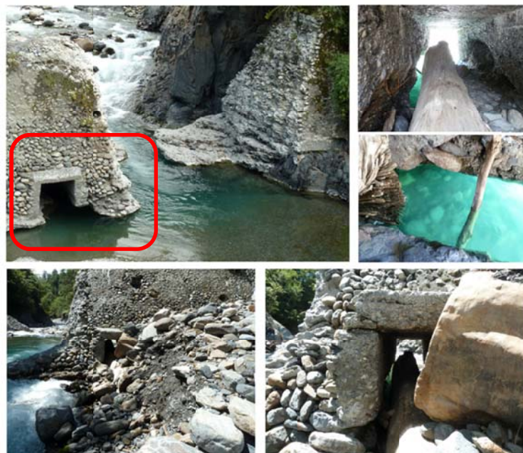
圖 4-12 一號壩殘存壩體壩基現況
