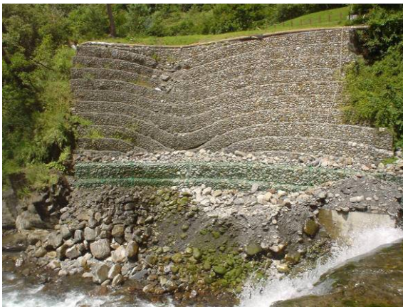
圖 3-8 右岸蛇籠工程
