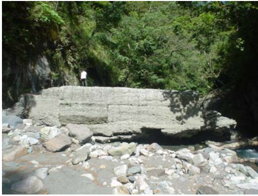
圖 3-35 七家灣溪五號壩全景
