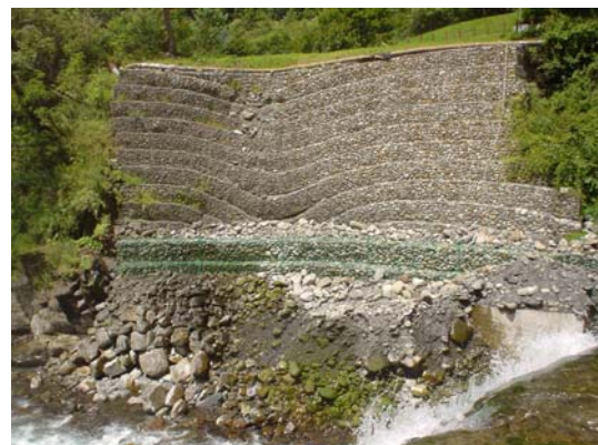
圖 3-56 右岸蛇籠工程
