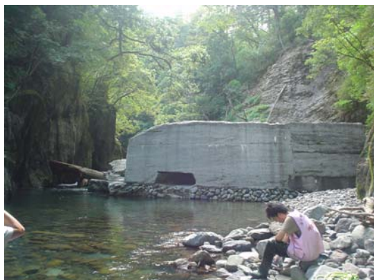
圖 3-33 七家灣溪五號壩全景
