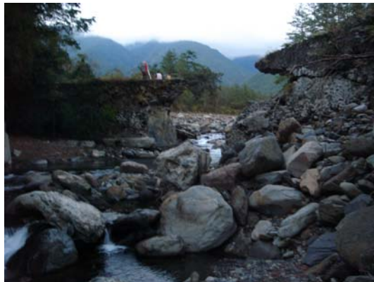
圖 3-51 七家灣溪二號壩破壩後
