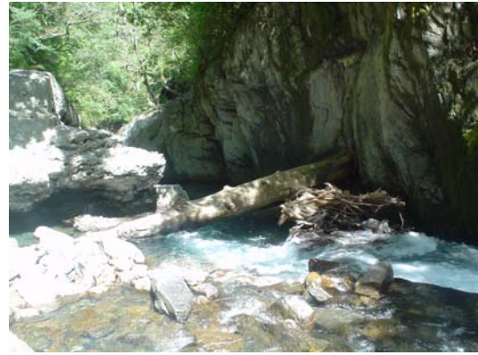
圖 3-36 七家灣溪五號壩全景
