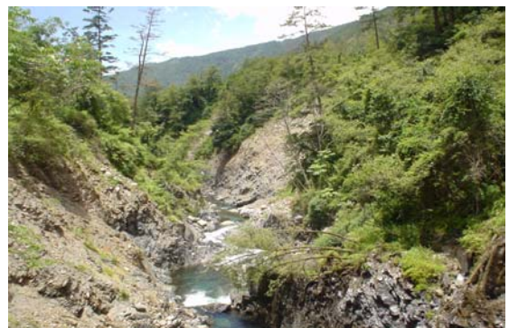
圖 3-60 三號壩下游崩塌
