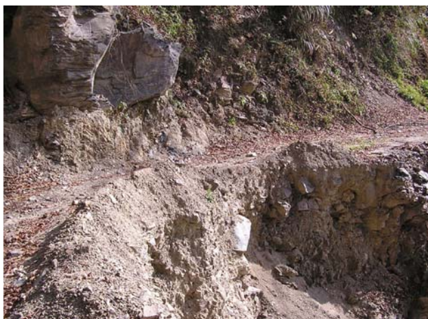
照片1、大鹿林道東線9至10k地基流失狀況 (2009. 3. 1)
