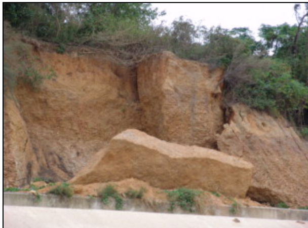
▲北山崩塌的崖壁露出化育中的貓公石
