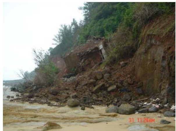
烈嶼玄武岩海岸於珍珠颱風時整個碇堡崩塌
