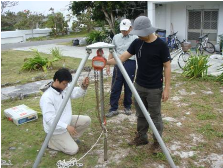
圖 4.9 以吊車輪組將取樣管取出之情形
