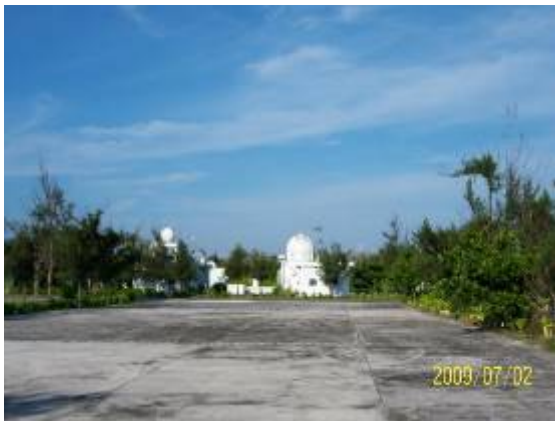
(A)雨水集水廣場
