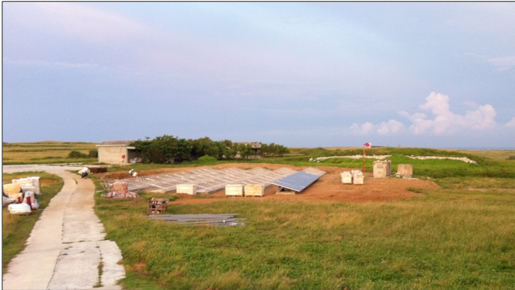
圖 2-5 東吉嶼太陽能微型電網設置工程現況
