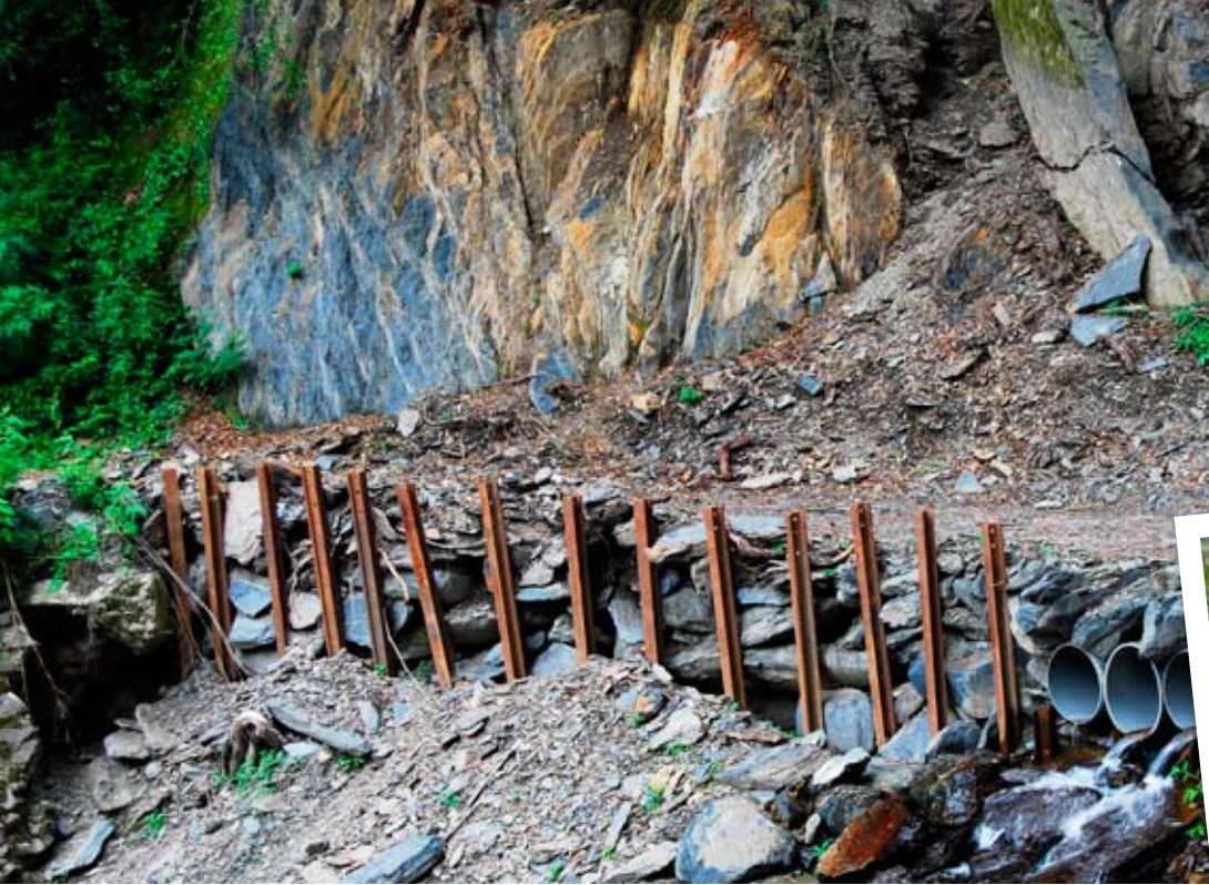
從國家公園常需實踐生態工程。圖為雪霸國家公園之大鹿林道維持原有的碎石路面供遊客通行 / 賴宛靖攝
