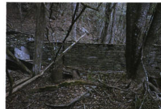
圖 11 Mongnavan-26 號家屋側牆疊石極為工整
