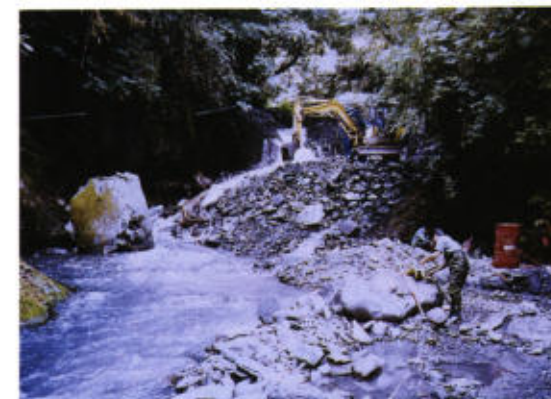
照片 3. 高山溪三號壩施工(89 年 10 月)
