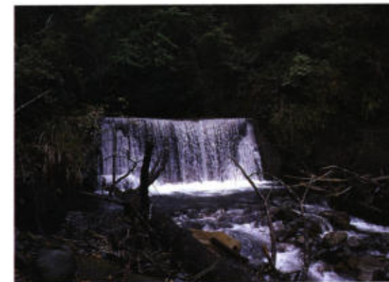
照片 1. 高山溪四號壩施工(88 年 3 月)
