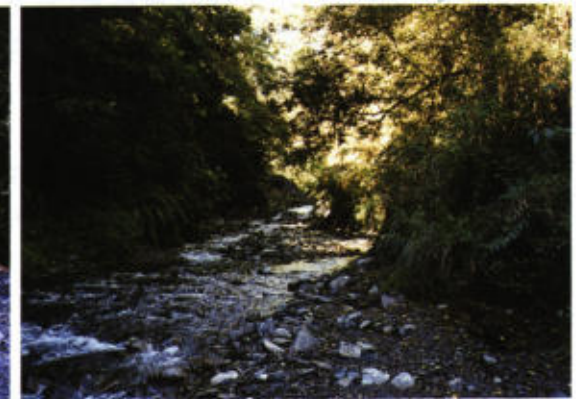
照片 4. 完工後之高山溪三號壩(89 年 11 月)
