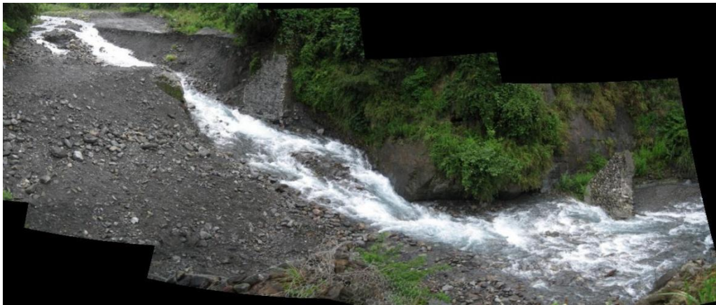
圖 5. 壩體改善工程後之七家灣溪一號壩河段(拍攝於 2011/6/2，照片由左至右為上游至下游)
