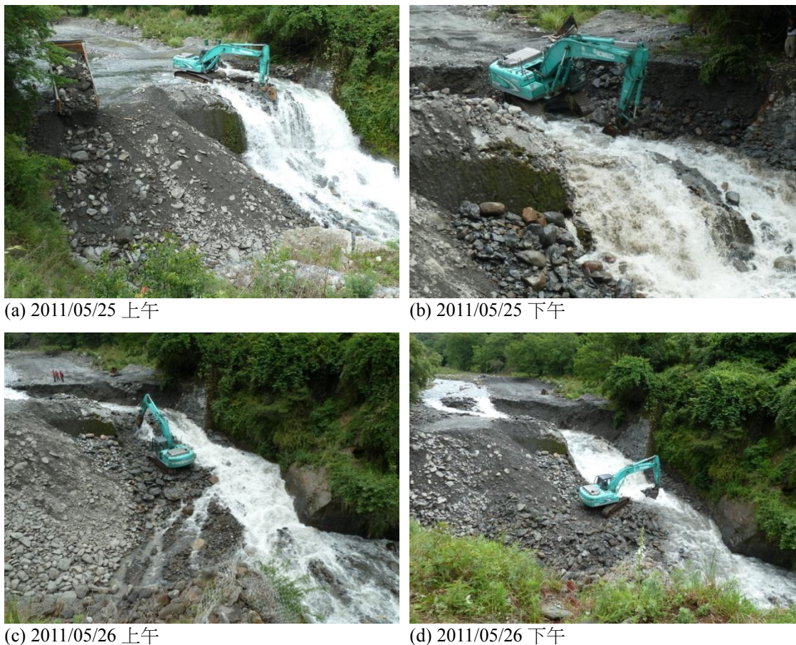
圖 4. (a) 砂石回填工程完成，壩體拆除工程開始; (b) 壩體拆除寬度已達預計拆除寬度十公尺; (c)、(d) 持續向下拆除
