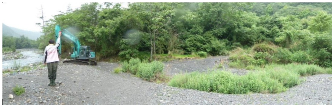
圖 2. 施工便道(拍攝於 2011/5/22)
