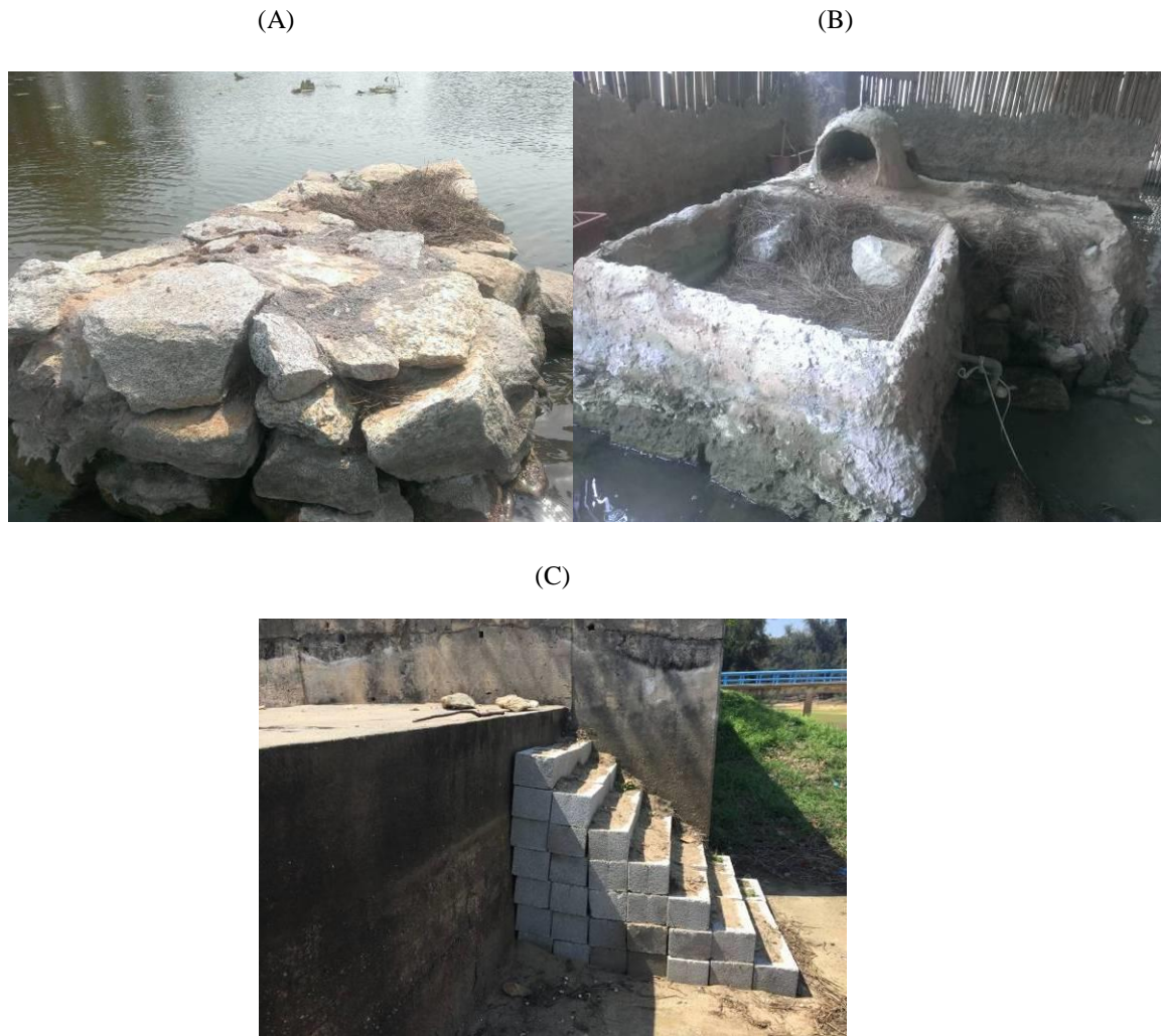
圖 2. 金門地區歐亞水獺棲地改善設施(A)雙鯉濕地自然中心之人工浮島 A，(B)雙鯉濕地自然中心之人工浮島 B 及(C)陽明水庫之人工階梯
