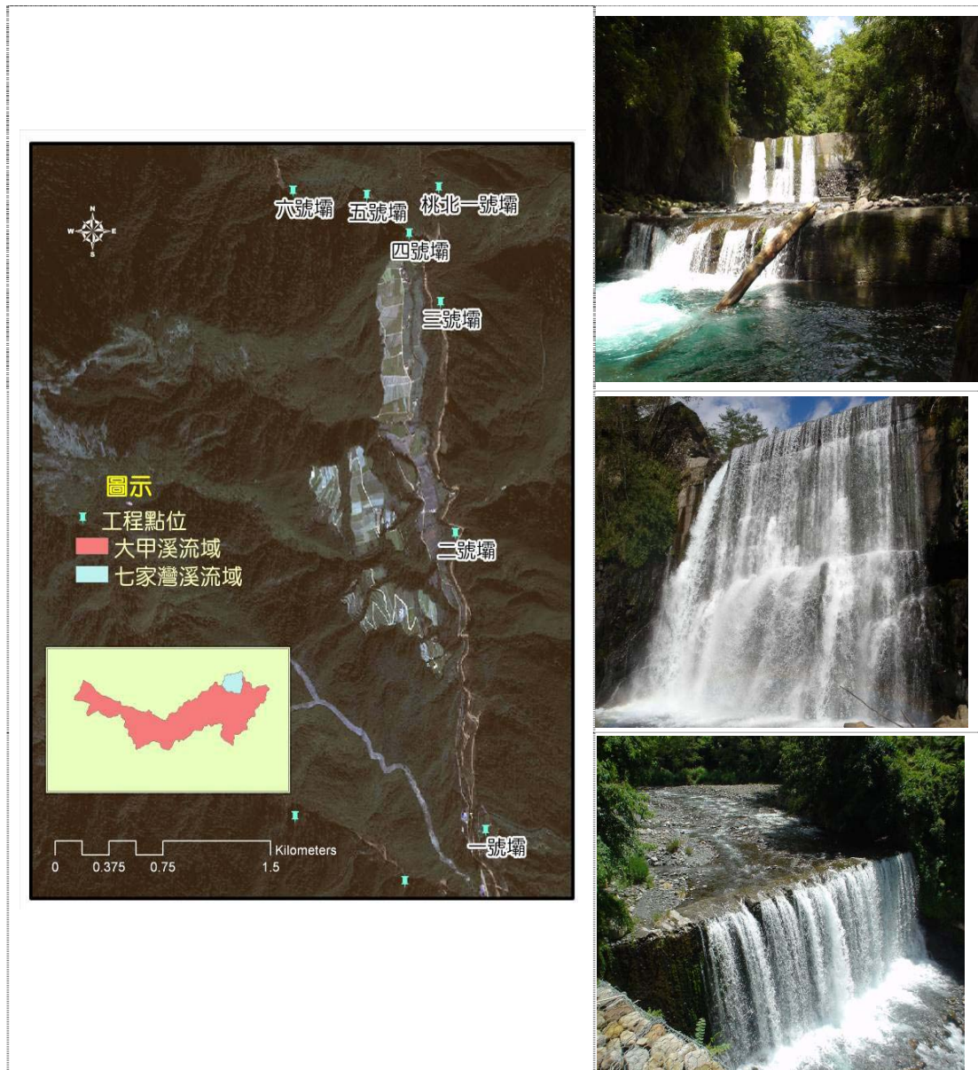
圖 3. 七家灣溪各防砂壩之空間分佈(左)及一號防砂壩(右上)、三號防砂壩(右中)及四號防砂壩(右下)之現場狀況
